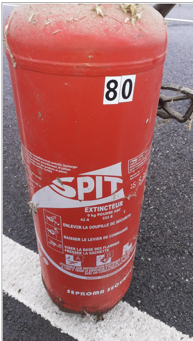
Extincteur à poudre de 9 kg disposé au pied du conteneur de désactivation des résidus de phosphure d'aluminium par voie sèche
